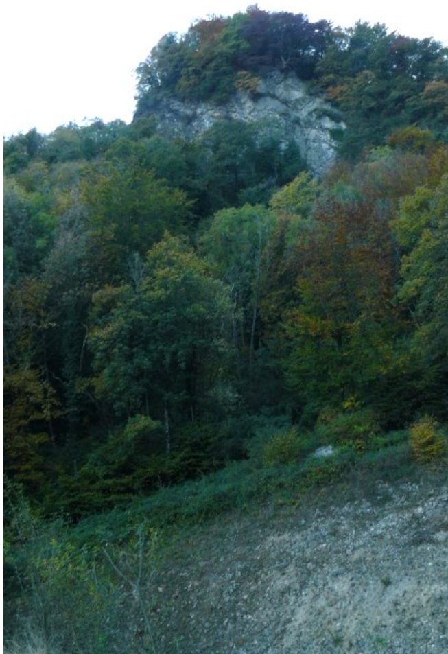
Profil 2 : corniche unique. Calcaires du Fontanil. Blocs 1 à 2m3
